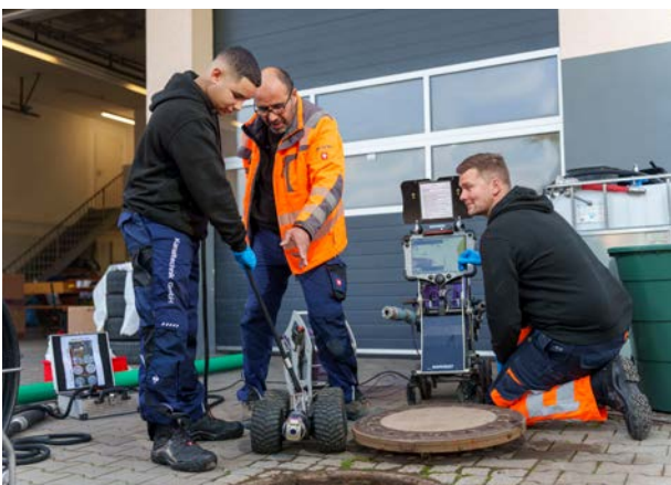
Abbildung 8: Schachtinspektion mit Inspektionskamera (Quelle: VDRK)
