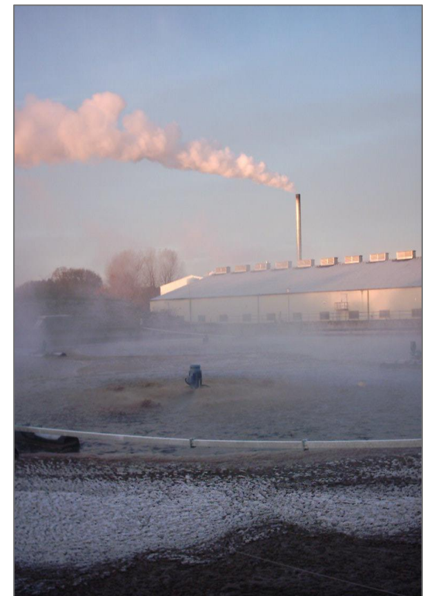
Belebungsbecken, © Wasserverband Gifhorn
