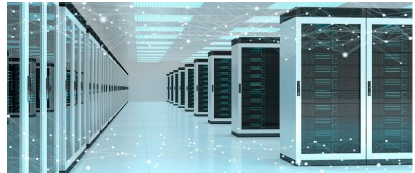
Serverraum in einem Rechenzentrum © Fotolia.com - sdecoret
