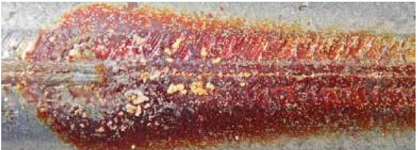
Längsschweißnaht eines Rohres mit Korrosionsangriff von außen
