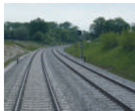
Zweigleisiger Teilausbau der Strecke
