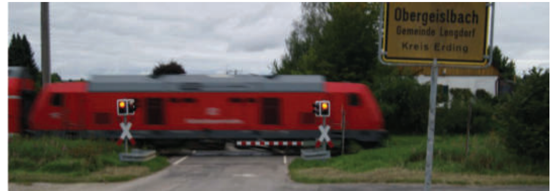
Nah Obergeislbach wird künftig die Walpertskirchener Spange in die ABS 38 einmünden.
